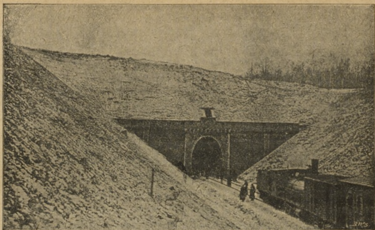
Rys. 121. Tunel pod Miechowem.
